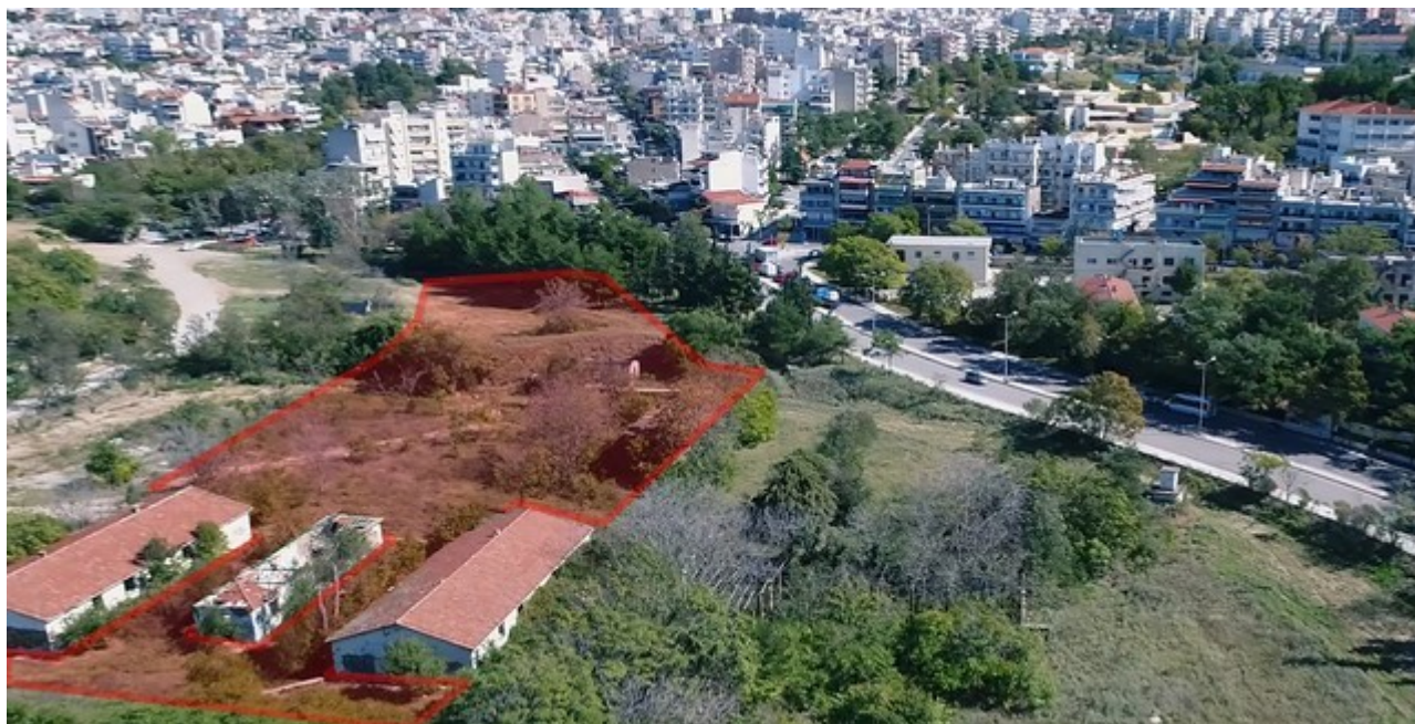
Εικόνα 52. Αεροφωτογραφία, περιοχή 3. ©Βαγγέλης Αμεράνης
