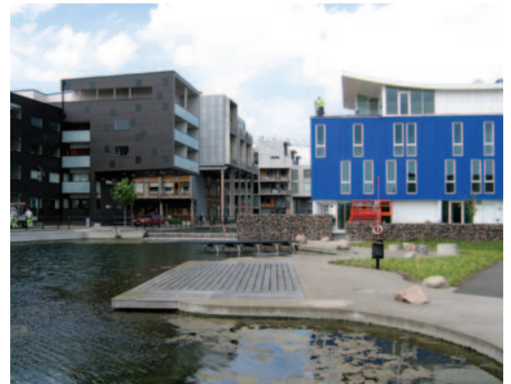
μέση: Αεροφωτογραφία της οικο-γειτονιάς στο Malmö Σουηδίας κάτω: Η οικο-γειτονιά Bo01 στο Malmö Σουηδίας δίπλα: Η οικο-γειτονιά Hammarby στη Στοκχόλμη
