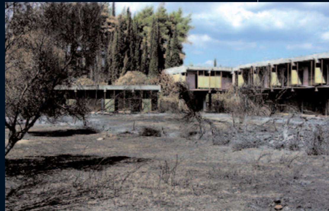
Το Μοτέλ «Ξενία-2» του αρχιτέκτονα Α. Κωνσταντινίδη στην Ολυμπία μετά τις φωτιές [φωτ. Ν. Καζέρος]
