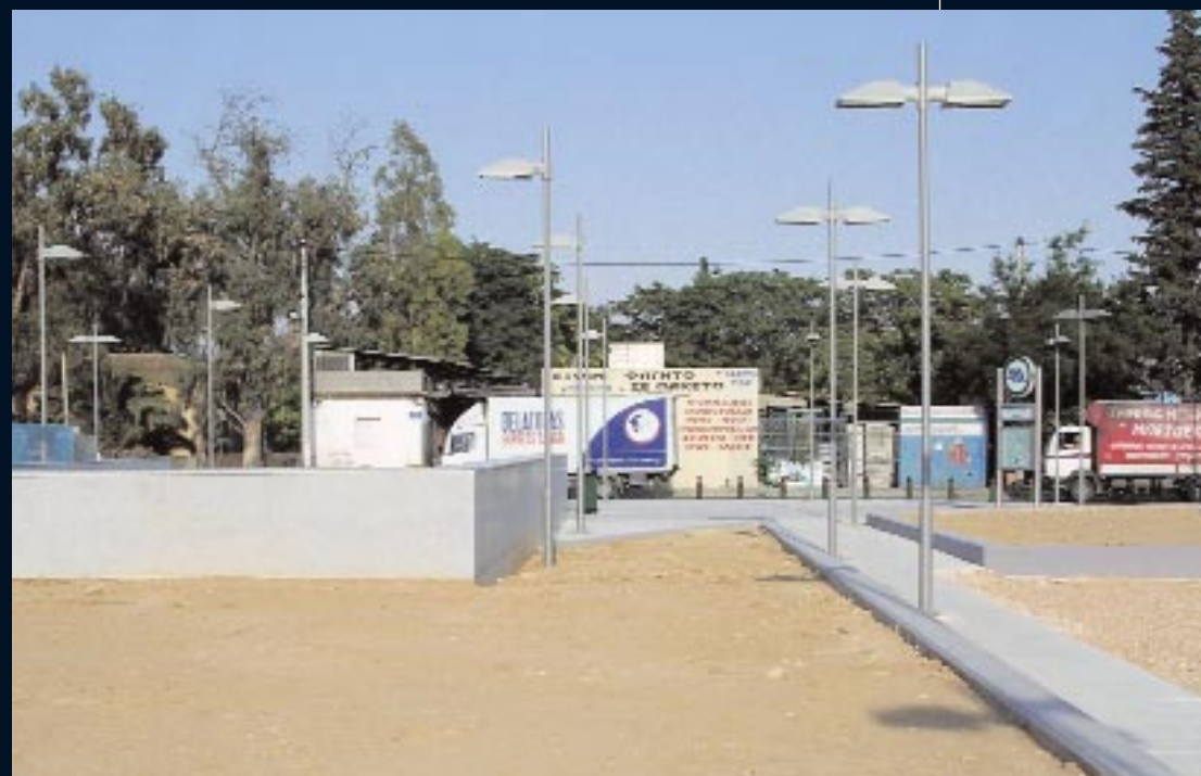
Ο νέος σταθμός του μετρό στον Ελαιώνα
