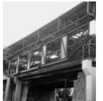
Η νέα γέφυρα του Γοργόπαταμου, ακόμη προσπαθώ να καταλάβω τι σπρίζει το δικτύωμα. Κάτω από τις γραμμές του τράνου, φαίνεται η σιδηροκατασκευή που τις σπρίζει. Σε πολλαπλάσιο βάρος και δυναμικές καταπονήσεις η κρέμαση της δοκού είναι λιγώτερη από την μισή του δικτύωματος που σπρίζει μόνο την στέγαση
