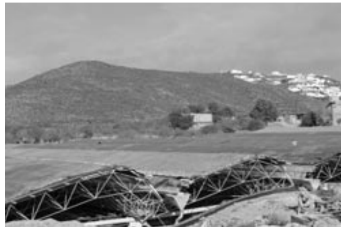
αριστερά: Εξωτερική φωτογραφία του στεγάστρου με τη φύτευσή του, δεξιά: Γενικό τοπογραφικό του στεγάστρου όπου σημειώνεται η θέση και η έκταση του ατυχήματος
