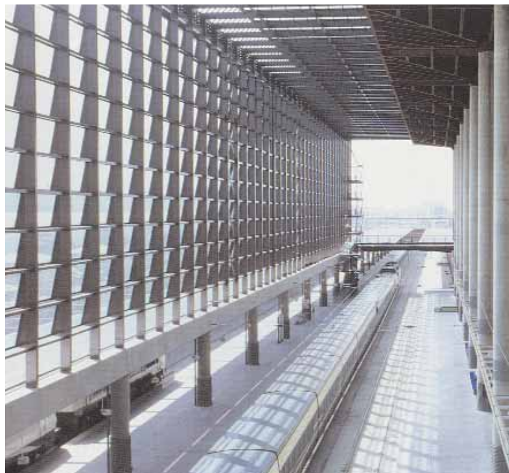
σελ. 62: Σταθμός Avignon TGV, Γαλλία, αρχιτέκτονες AREP
