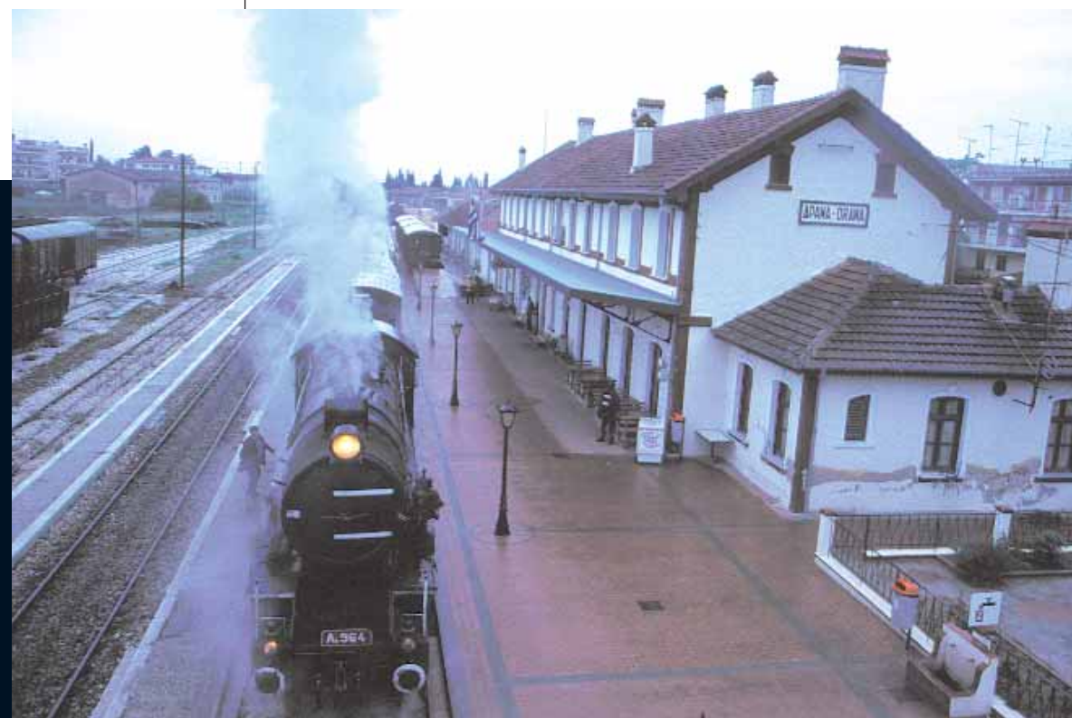
ΣΣ Δράμας. Ένας χαρακτηριστικός βαλκανικός σιδηροδρομικός σταθμός
