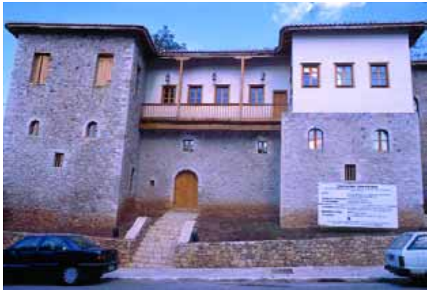
πάνω: Αρχοντικό Παλαιοιογίνας στα Καλάβρυτα (18ος αι.). Νότια όψη του μνημείου πριν και μετά την εκτέλεση εργασιών στερέωσης, αποκατάστασης και ανακατασκευής του κατεστραμμένου κεντρικού ορόφου και της στέγης (1997-2001)
