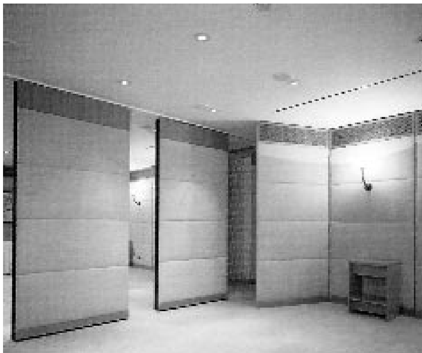
πάνω: Ηχομονωτικά κινητά χωρίσματα με ηχοαπορροφητική επένδυση μέση δεξιά: Σύνθετη ηχοαπορροφητική διάταξη πολλών «ηχοδιαπερατών» στρώσεων
