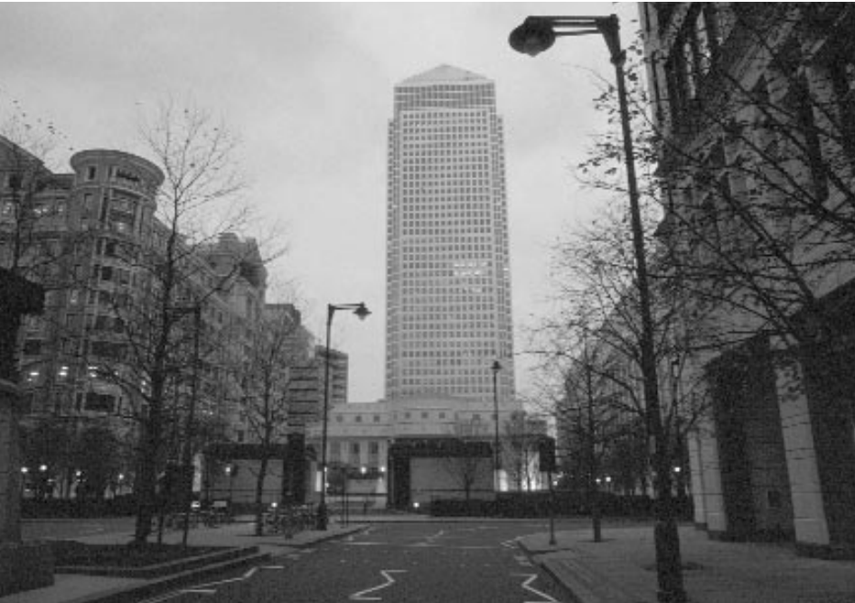
πάνω: Άποψη των Docklands του Λονδίνου (στο κέντρο ο πύργος του Canary Wharf:το νέο χρηματιστηριακό κέντρο του Λονδίνου), με έρημους τους κεντρικούς δρόμους σε ώρα που τα κτίρια γραφείων είναι κλειστά, φωτ. Εμ. Μαρμαράς, 1994
