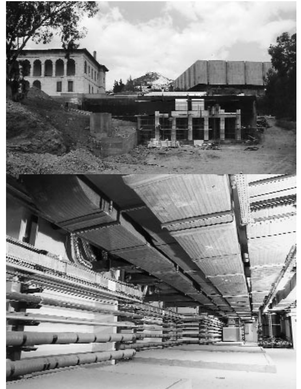
μέση: Κατασκευή όψεως από την οδό Βασ. Κωνσταντίνου κάτω: Τμήμα μηχανολογικών εγκαταστάσεων
