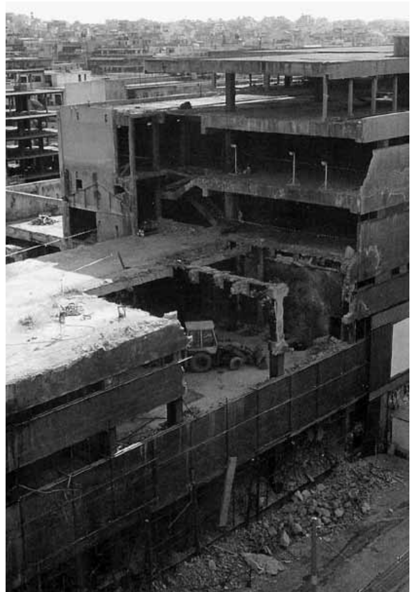
Η κατεδάφιση του κτηρίου τον Μάρτιο του 1995
