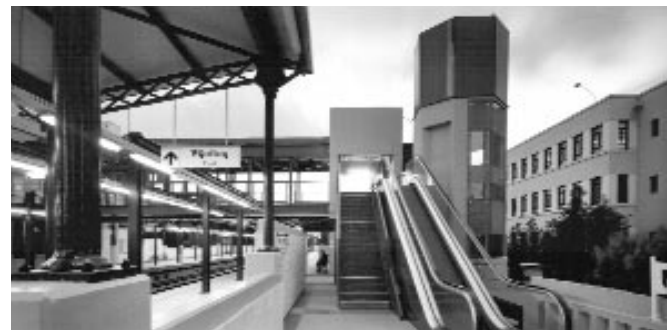
Ο Σταθμός ΗΣΑΠ Καλλιθέα όπως κατασκευάστηκε
